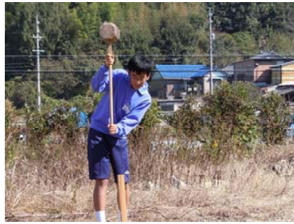
レベルでの水準測量 (右) 掛矢をふって測点杭設置 (下)
