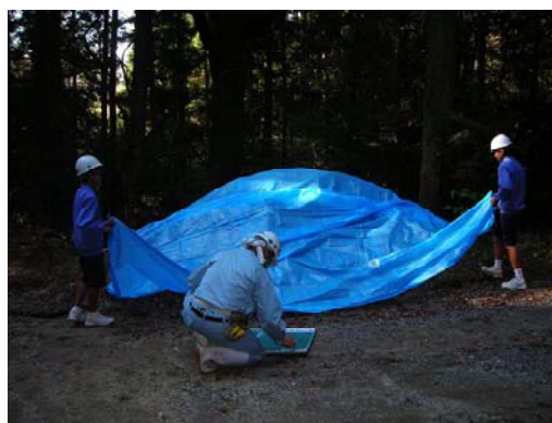
土砂流出養生作業
