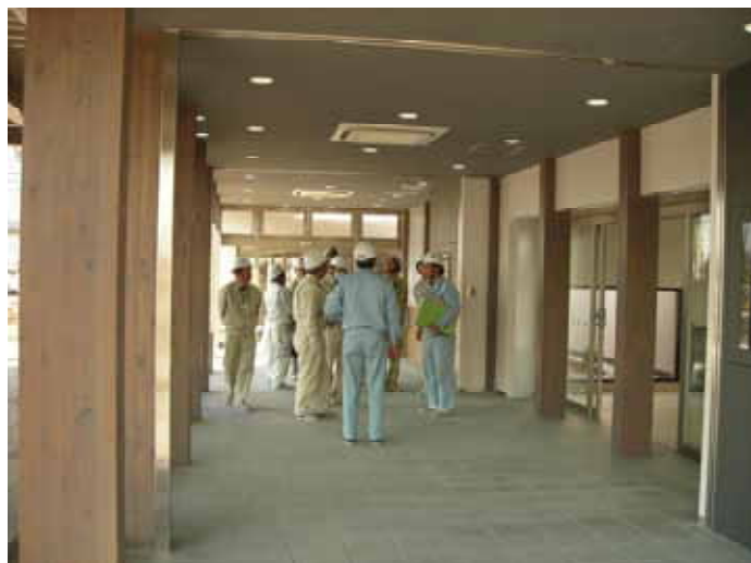
トイレ・情報施設棟内部の検査風景
