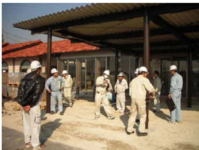
身障者上屋の出来形寸法測定状況
